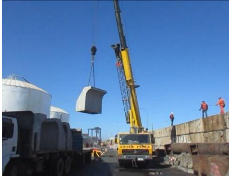
Figura 7: Instalación de bloques verteolas prefabricados.
